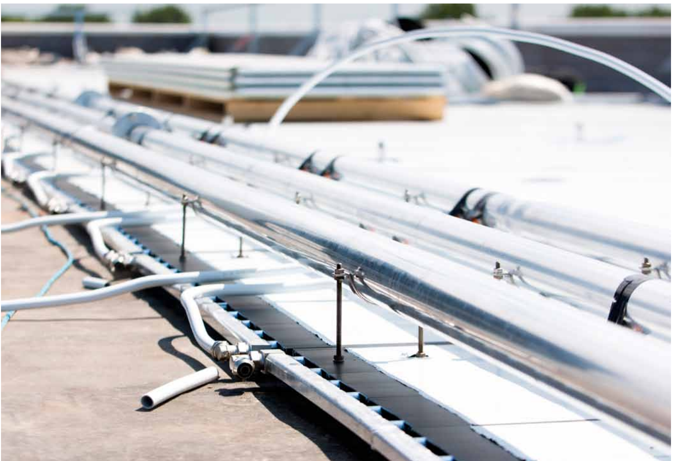
HET TRIPLE SOLAR ENERGIEDAK BLIJFT, TOTDAT DE INSTALLATIE- EN DE BOUWERKZAAMHEDEN AFGEROND ZIJN, AFGEDEKT MET EEN BESCHERMFOLIE
