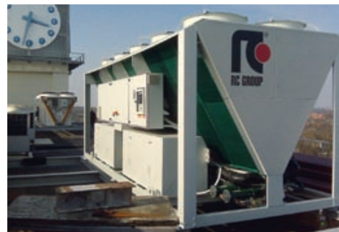
De droge koeler op het dak van een kantoor van het Eindhovense stadsdeel Strijp-S. In de zomer voert deze koelte af en levert warmte aan de bron. Dat is nodig vanwege de grote warmtevraag van de gebouwen in de winter.
