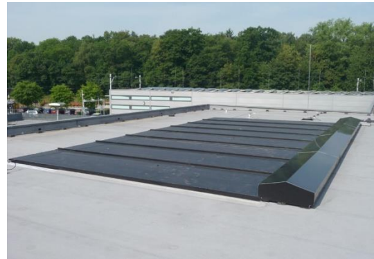
Afb.7: optioneel afwerken met zetwerk
