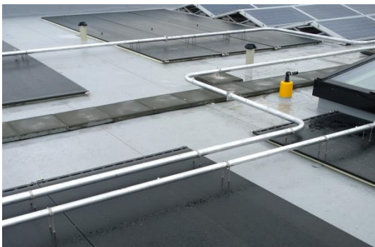
Afb.3: plaatsen van de collectoren
