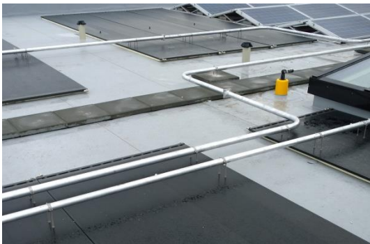
Afb.3: plaatsen van de collectoren
